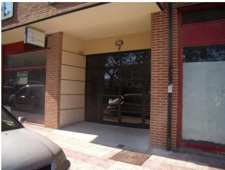
La rampa de acceso al portal ha sido ejecutada con dos rampas sucesivas de pendientes 4,00%, el 1<sup>er</sup> tramo (se considera itinerario horizontal) y 10,00%, el segundo, con saliente respecto línea de fachada  $\approx$  **32 cm**
