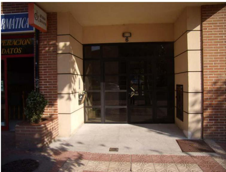
La rampa de acceso al portal ha sido ejecutada con dos rampas sucesivas de pendientes 4,00% (el 1er tramo↔se considera itinerario horizontal) y 7,40%, el segundo, con saliente respecto línea de fachada  $\approx 90$  cm La rampa no invade la zona de uso peatonal de la acera al existir una jardinera de ladrillo adosada a la fachada. El encuentro lateral de la rampa con el pavimento existente se ha realizado con rampas de acuerdo con pendientes inferiores al 6%.
