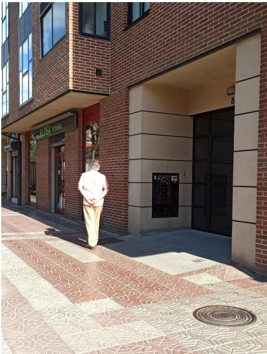
Deberá reducirse la pendiente de los planos inclinados laterales / rampas de acuerdo y señalizarse el inicio de la rampas de acuerdo, con franjas señalizadoras, de pavimento táctil indicador, de tipo direccional, colocado en sentido transversal a la marcha (tránsito peatonal) al inicio de la rampa de acuerdo
