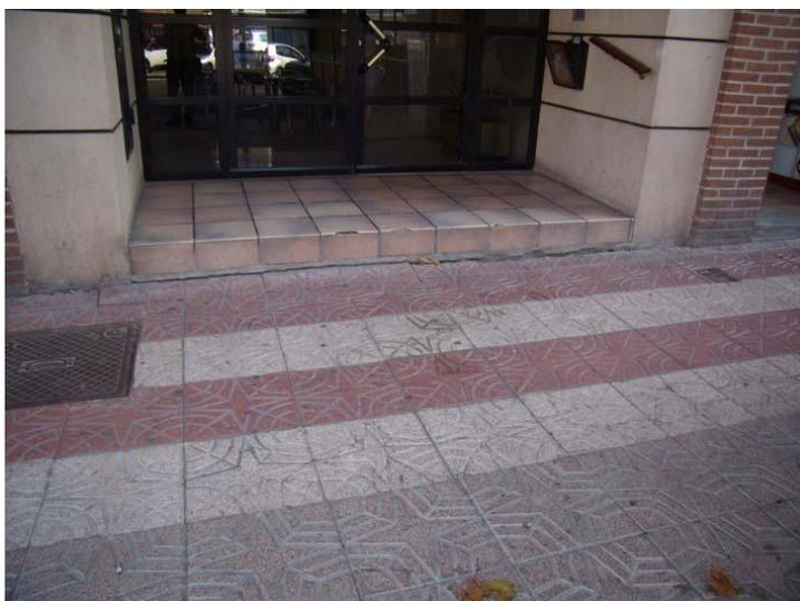
La acera, en el entorno inmediato del portal, tiene un hundimiento considerable y se manifiesta con un charco en momentos de lluvia. Se plantea corregir el hundimiento de la acera y aprovechar para disminuir la altura del peldaño. El peldaño actual tiene 21 cm y quedará con un desnivel de 11 cm fácilmente resoluble mediante rampas frontales.
