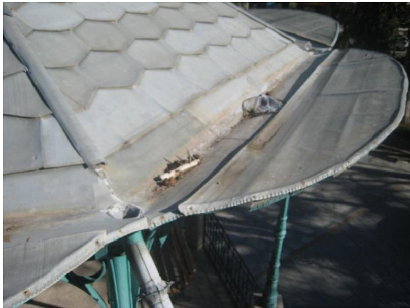
El encuentro entre la cubierta y las vigas metálicas, se resuelve mediante la ejecución de una lima, que evacua las aguas por cada uno de los pilares a través de 8 gárgolas de zinc. Esta lima que rodea perimetralmente el templete se adorna mediante 8 viseras voladas realizadas con zinc y acabadas con tabla de madera por la parte inferior.
